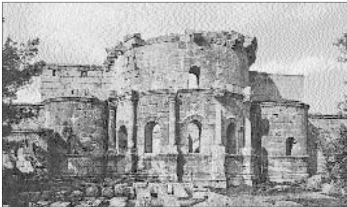
Bizans döneminde, Halep'in 60 km. uzağında inşa edilen Kalat Siman Kilisesi'nin doğu cephesi
